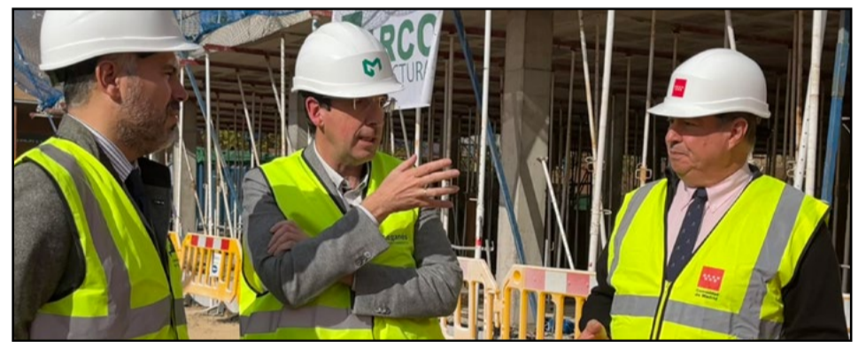
© CAM | La Comunidad de Madrid construye un Centro Cívico en Leganés con una inversión de 3,8 millones
