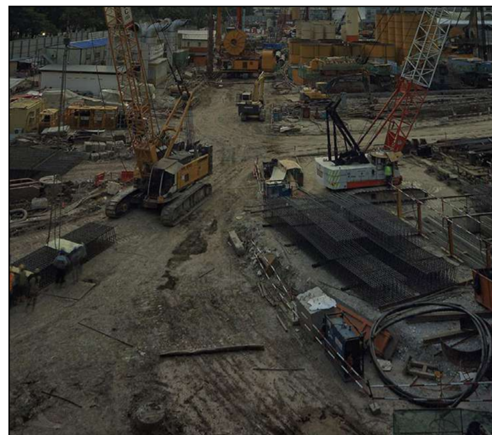
©Archivo | Obra en construcción
