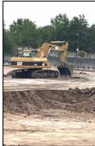
©LGN Medios | Obras del Emsule
